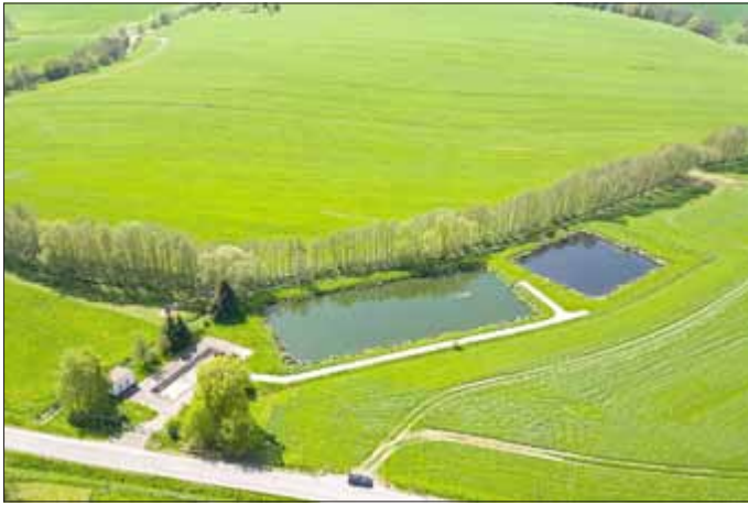
Innovation im Grünen: Die Kläranlage Günterode wird zur Musteranlage ausgebaut.
