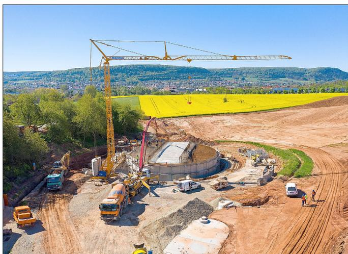
Mit großem Gerät und Man-Power wurde die Decke des Hochbehälters im Gewerbegebiet „An der A38–Ost“ gegossen.
